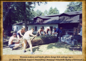
Wymiana podłopy pod listwy główne dużego koła wodnego, 1991 r. (Ze zbiorów Wydziału Inżynierii Materiałowej i Metalurgii Politechniki Śląskiej w Katowicach.)
