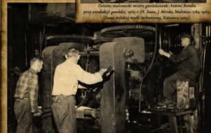
Walcowanie blachy stalowej z fragmentów zużytych kół kolezowych, 1965 r. (A. Sawa, J. Mirski, Maleniec 1984-1985. Dłma polskiej myśli technicznej, Katowice 1985).
