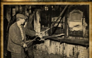
Intensywowanie trybu łopaty przez jej obróbkę w prasie mechanicznej, 1965 r. (A. Sawa, J. Mirski, Maleniec 1984-1985. Dłma polskiej myśli technicznej, Katowice 1985).
