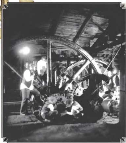
Prace remontowe przy przekładni zębatej (fot. Atelier Historyczny z Łużycami)
