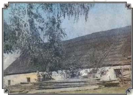
Budynek gwoździarni na terenie malenieckiej fabryki żelaza (ok. 1955 r.) Źródło: S. Herbst, Walcownia w Malencu , „Ochrona Zabytków” 1951, nr 3-4, s. 120.
