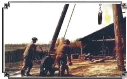
Lamanie obręczy kół wagonowych w maleńckiej fabryce żelaza (ok. 1955 r.)
