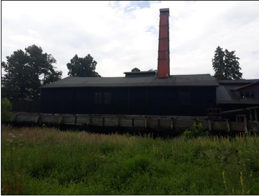
Hala produkcyjna 2. Walcownia. Widok od strony północnej
