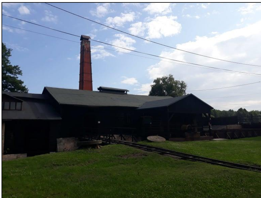
Hala produkcyjna 2. Walcownia. Widok od strony południowej
