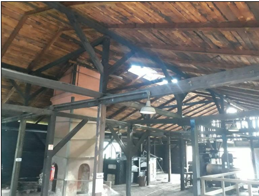
Hala produkcyjna 2. Walcownia. Widok wnętrza
