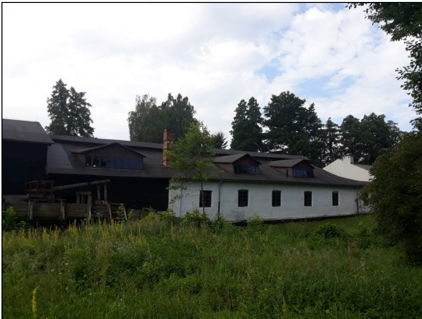
Hala produkcyjna 1. Gwoździarnia. Widok od strony północnej
